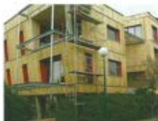
Fachada en construcción.
