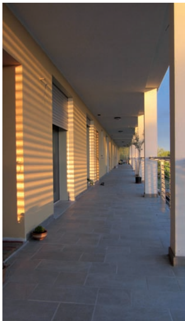
Figura 10 - Il ballatoio comune
