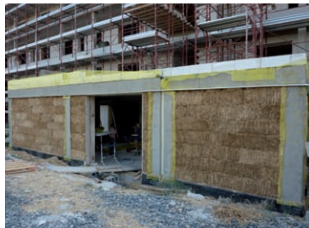
Figura 7 - Tamponamento in paglia del salone comune
