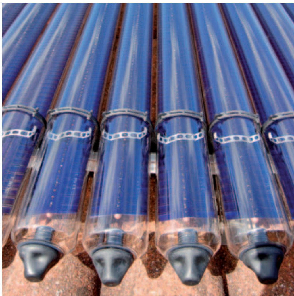
Particolare di un pannello solare termico
