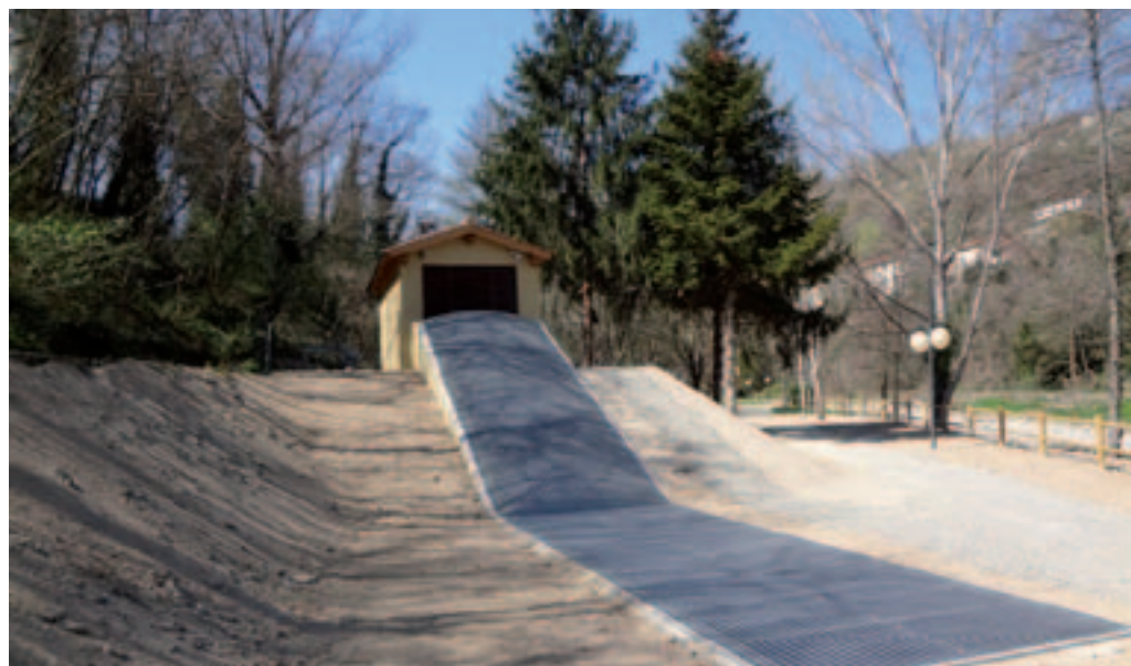
Impianto mini idroelettrico, Comune di Prato
